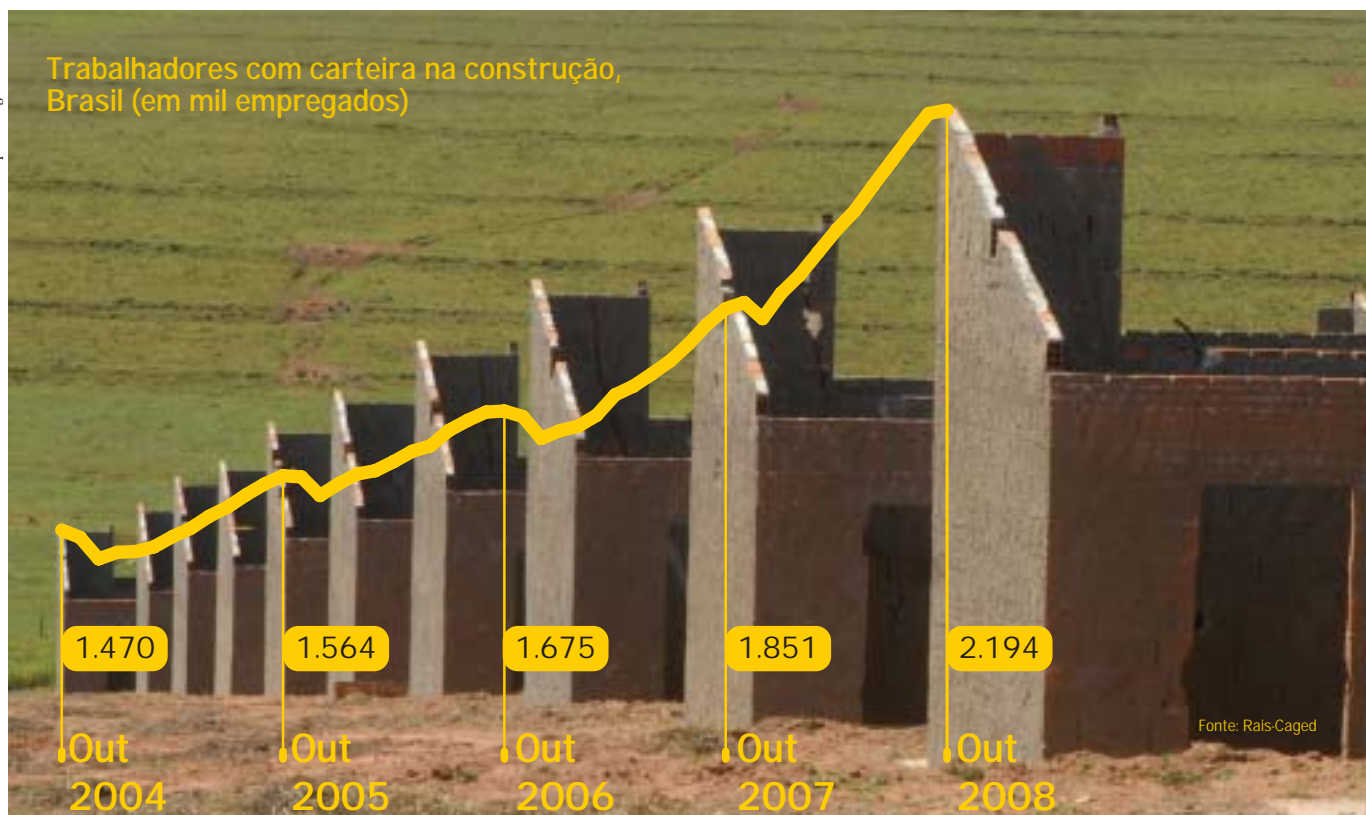
Casas populares em construção em Borá (SP)
